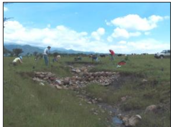
Figura 5. Represas de piedra y plantaciones para controlar la erosión y detener el crecimiento de cárcavas.
